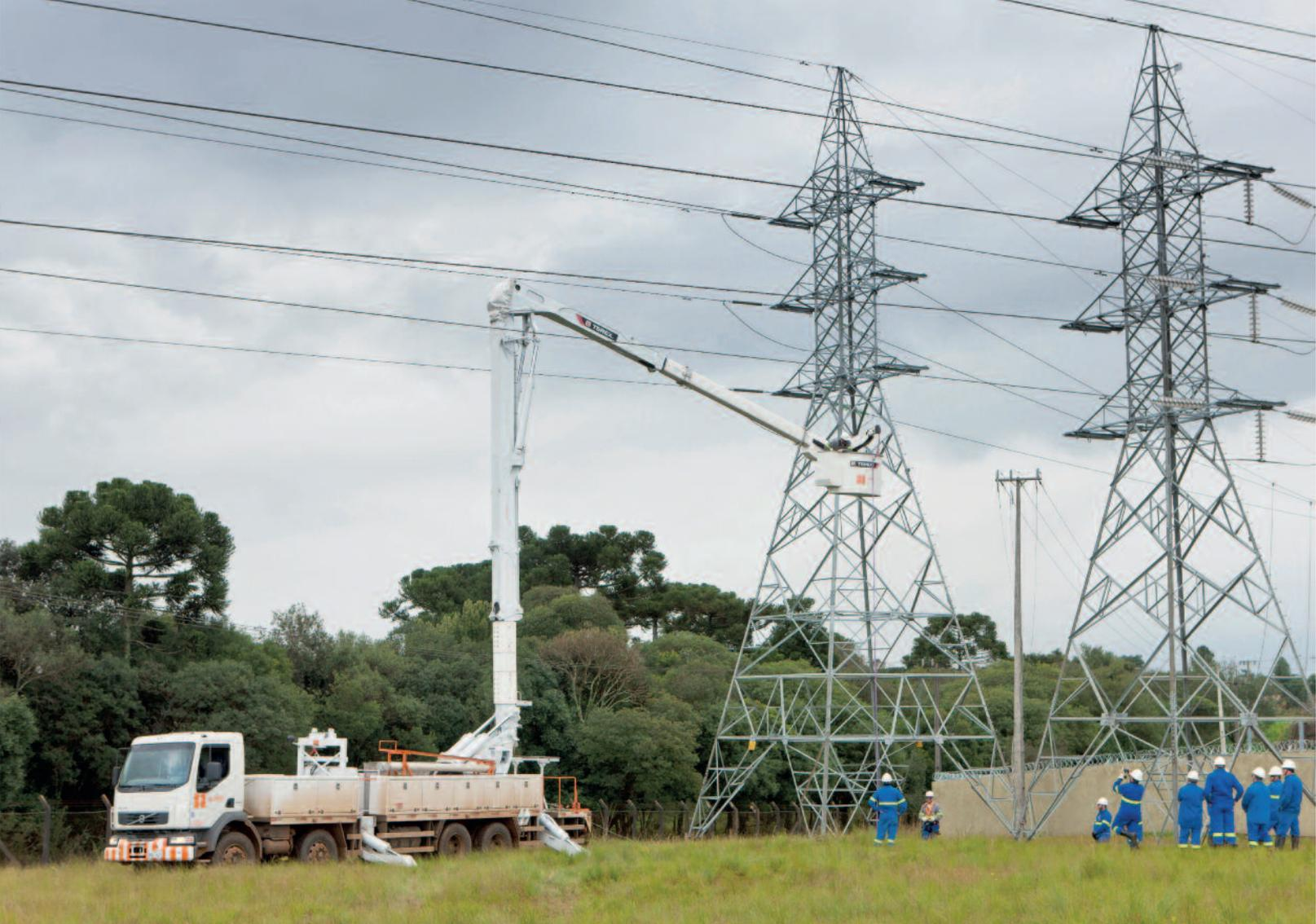
Na Copel, a previsão é que, a princípio, o equipamento, do modelo Linesman TM 105, sirva para manutenção de linhas de 69 kV a 138 kV. “Mas poderemos operar com até 500 kV e a 32 m de altura sem interromper o fornecimento de energia, quando o usual, nessas situações, seria desligar a rede”, explica Dias.
