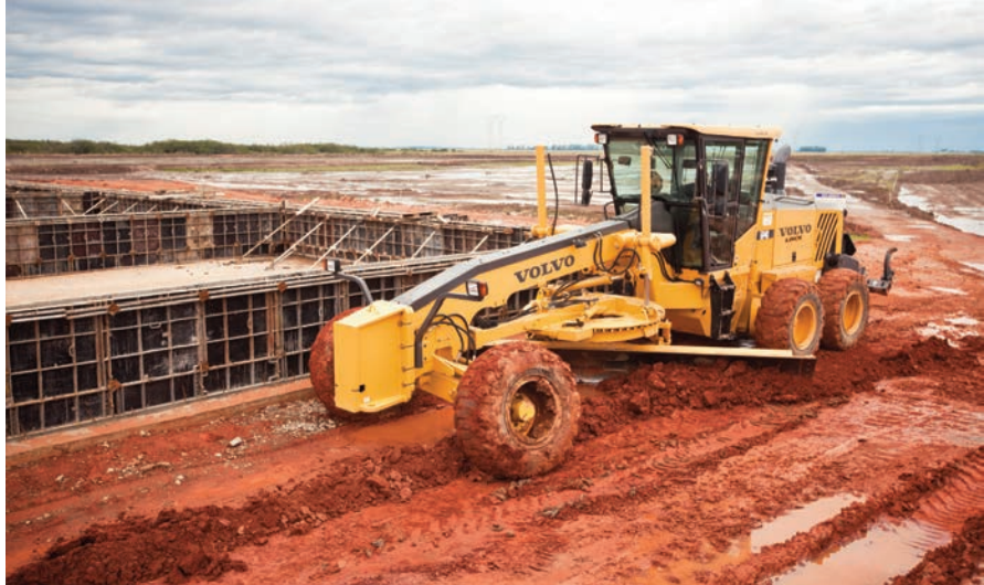
Motoniveladora da Volvo Rents em obra no Rio Grande do Sul. Crescimento do país nos próximos anos, com investimento em infraestrutura, faz da locação de equipamentos um negócio ainda mais atraente
